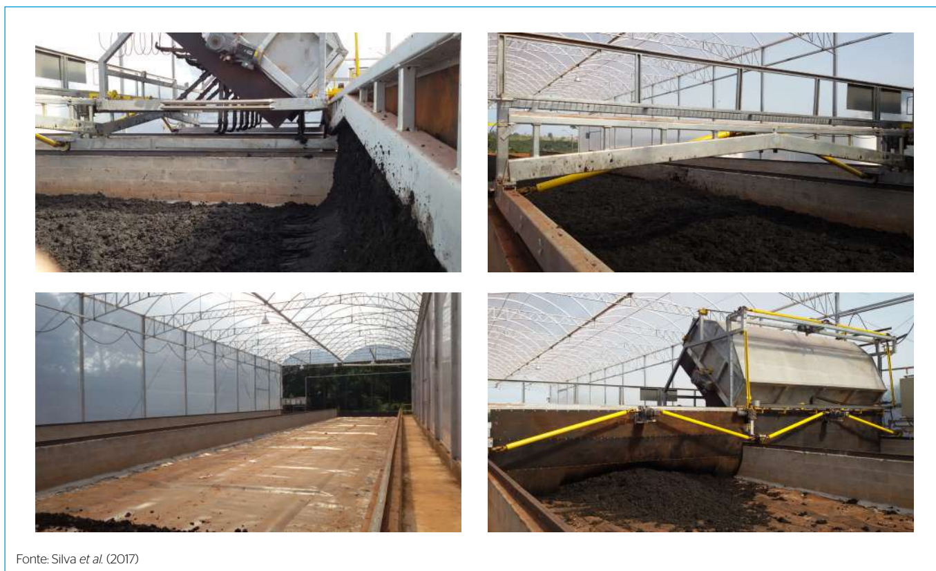
Figura 2 – Sistema de secagem e compostagem em estufa, ETE Lageado, Botucatu, SP.
